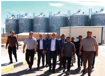
Un chantier modèle à Laâyoune : le centre de stockage de Selmana
